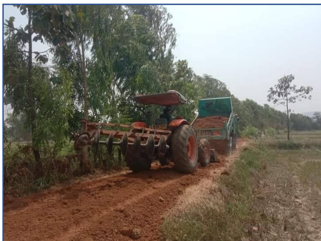
๔. ลงลูกรัง สายทางหนองก้านเหลือง หมู่ที่ ๔ บ้านนางอย
