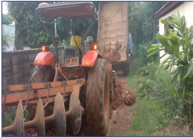
๒. ลงลูกรัง สายทางข้างสถานีบริการน้ำมัน PT หมู่ที่ ๒ บ้านเต่างอยเหนือ
