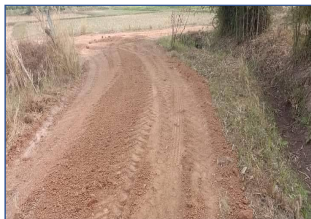
๓. ลงลูกรัง สายทางที่นางน่าน ดวสายวา-ที่นายนายโยธิน หาแก่น หมู่ที่ ๔ บ้านนางอย
