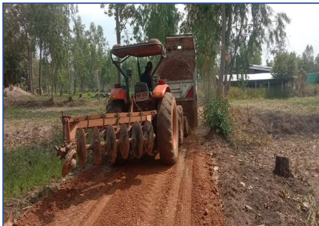
๔. ลงลูกรัง สายทางคำผักกูด-นาคำยาง หมู่ที่ ๔ บ้านนางอย
