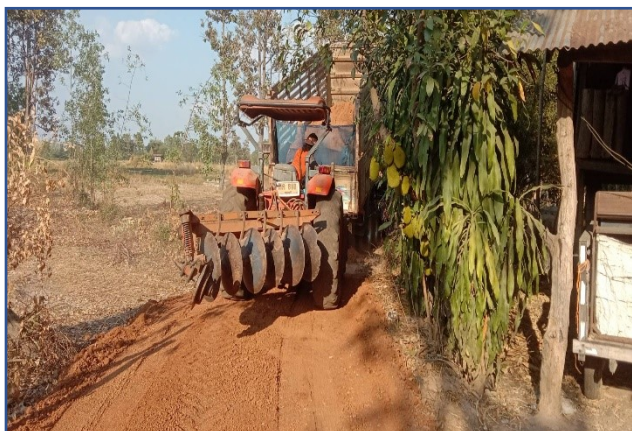
๓. ลงลูกรัง สายทางที่นางน่าน ดวสายวา-ที่นายนายโยธิน หาแก่น หมู่ที่ ๔ บ้านนางอย
